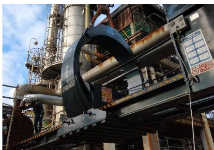
熱交換器の引抜用ツール
